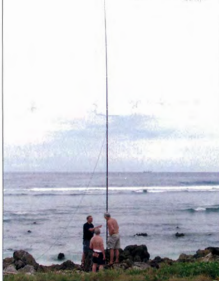
Antennenreparatur an der WARC-Vertikal
